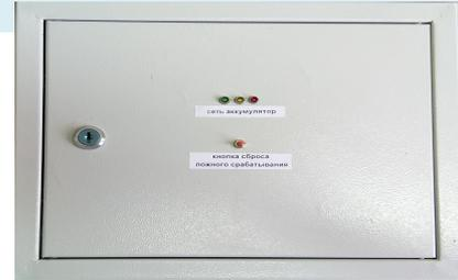
В случае нормальной работы, при напряжении в сети и в отсутствии аварийных ситуаций, должен загораться только зеленый светодиод.
